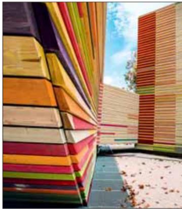
Detailaufnahme der Fassadenverkleidung mit lackiertem Lärchenholz
