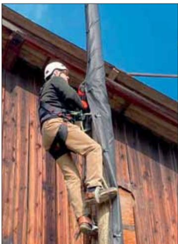
Das „Pecodur“-System soll Spechte dauerhaft vom Hacken an Holzmasten abhalten. Ein erster Feldversuch mit der Gewebeamantlung zeigt bislang vielversprechende Ergebnisse.
